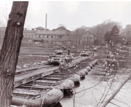
Die 87. US-Infanteriedivision überquert die Saale auf einer Pontonbrücke, 14. April 1945. (Quelle: Bildarchiv Stadtmuseum)
