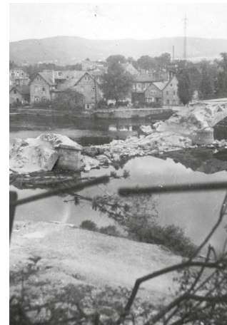
Saale-Brücke nach ihrer Sprengung am 13. April 1945. (Quelle: Bildarchiv Stadtmuseum)
