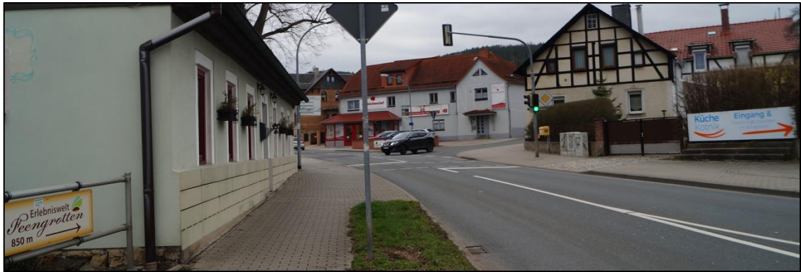
Abb. 34 Prüfung Lückenschluss Gehwegfreigabe LSA Gannrsdorfer Straße
