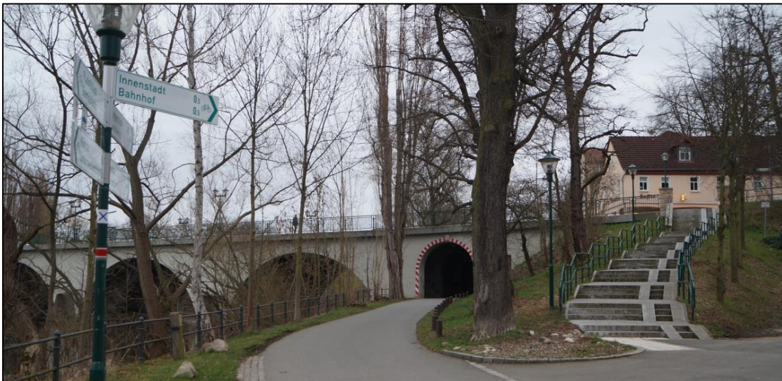
Abb. 21 Infrastruktur im Bestand - Wegweisende Beschilderung
