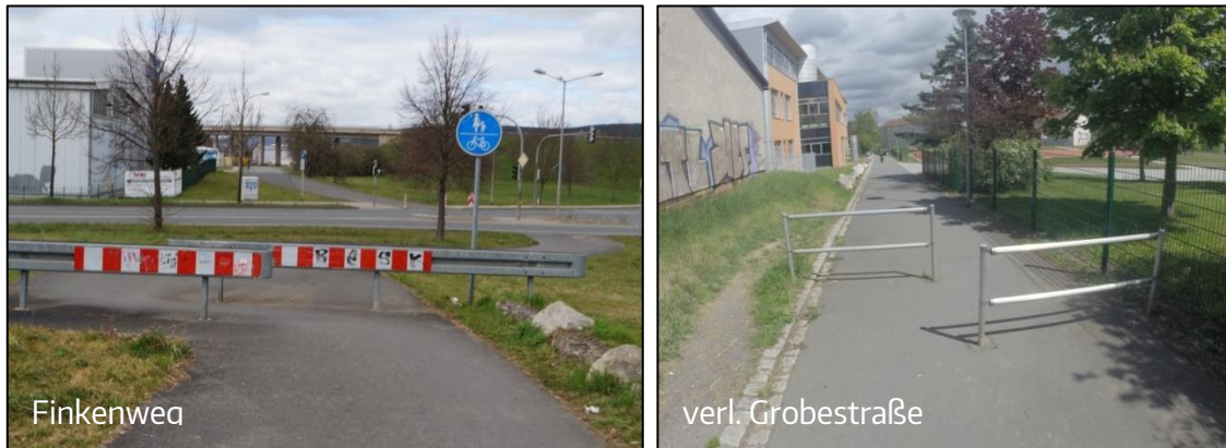
Abb. 16 Infrastruktur im Bestand - Umlaufsperrn
