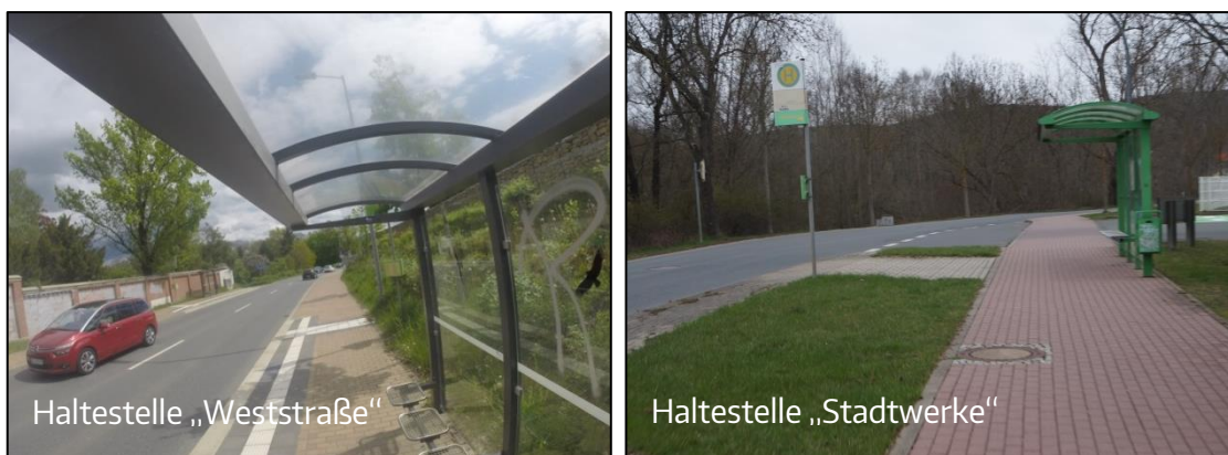
Abb. 18 Infrastruktur im Bestand - Durchfahrtshöhe Haltestellenunterstand
