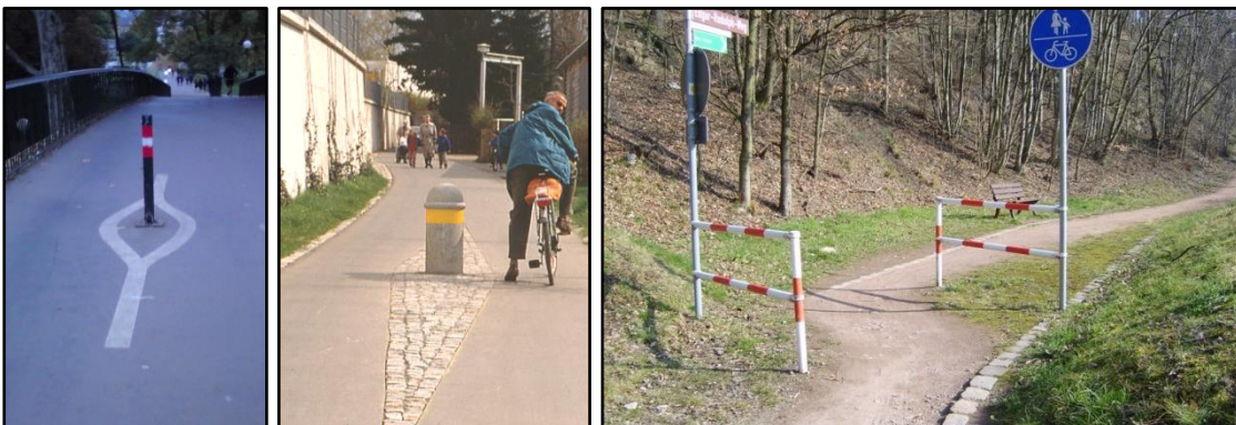
Abb. 36 Beispiele Verbesserung Verkehrssicherheit an Poller / Umlaufsperrn
