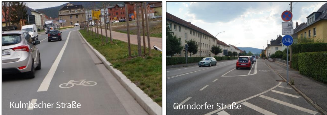
Abb. 2 Infrastruktur im Bestand - Radfahrstreifen
