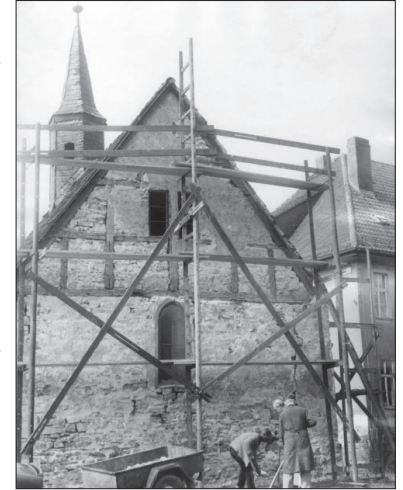
Martinskapelle während der Sanierung um 1983. (Quelle: Bildarchiv Stadtmuseum)
