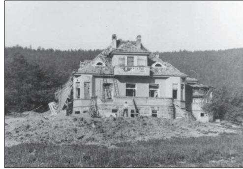
Zerstörte „Japanervilla“ am Frankenweg, Mai 1944. (Quelle: Bildarchiv Stadtmuseum)
